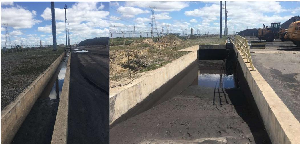
**Figura 9** Sistema de Drenagem do Pátio de estocagem
